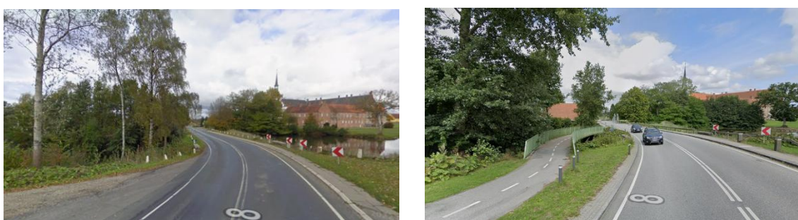
Figur 8. Reventlowsvej i Fåborg-Midtfyn Kommune ved Brahetrolleborg Slot. Fotos fra Google Streetview oktober 2010 før anlæg af stibro og dobbeltrettet cykelsti langs vej (til venstre) og august 2019 efter anlæg af stibro og dobbeltrettet cykelsti langs vej (til højre).
