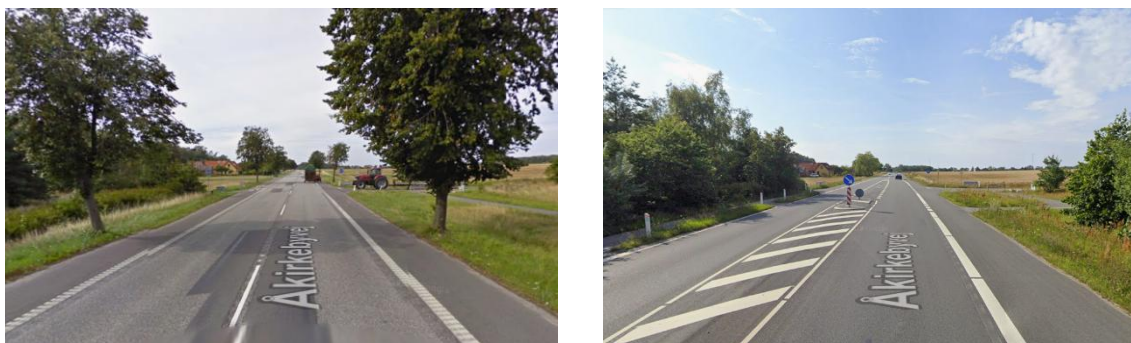
Figur 10. Åkirkebyvej i Bornholms Kommune sydøst for Rønne. Fotos fra Google Streetview september 2010 før anlæg af midterheller (til venstre) og august 2019 efter anlæg af midterheller (til højre).
