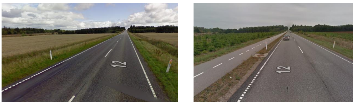
Figur 1. Vardevej i Herning Kommune nord for Kibæk. Fotos fra Google Streetview august 2009 før anlæg af dobbeltrettet cykelsti (til venstre) og august 2018 efter anlæg af dobbeltrettet cykelsti (til højre).
