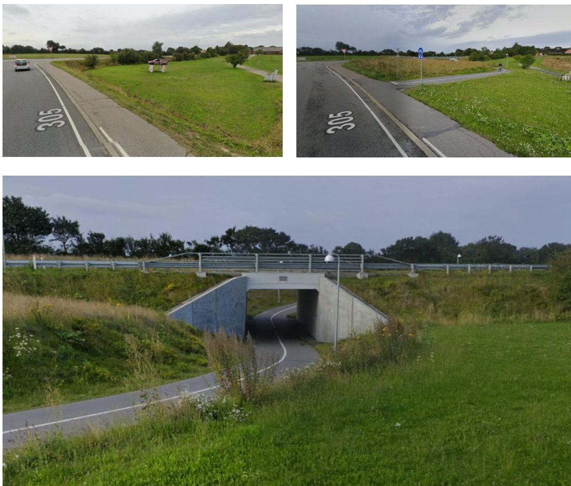
Figur 7. Nordre Landevej i Langeland Kommune nordøst for Rudkøbing. Fotos fra Google Streetview september 2021 før anlæg af stitunnel og dobbeltrettet cykelsti langs vej (øverst til venstre) og august 2025 efter anlæg af stitunnel og dobbeltrettet cykelsti langs vej (øverst til højre og nederst).
