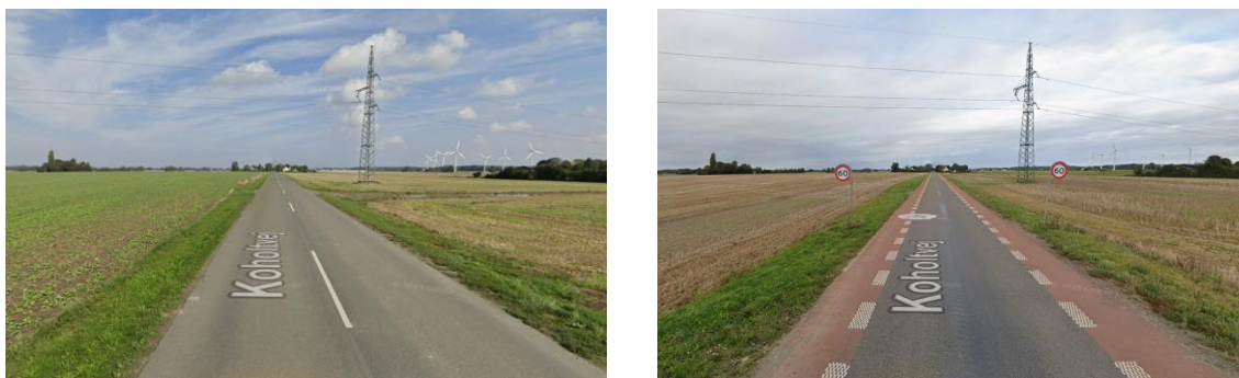
Figur 5. Koholtvej i Lolland Kommune nord for Nørreballe. Fotos fra Google Streetview september 2019 før anlæg af 2-1 vej (til venstre) og september 2025 efter anlæg af 2-1 vej (til højre).
