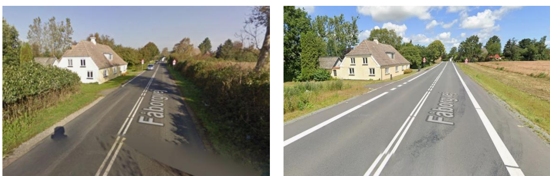
Figur 4. Fåborgvej i Assens Kommune syd for Køng. Fotos fra Google Streetview oktober 2010 før anlæg af kantbaner (til venstre) og juli 2019 efter anlæg af kantbaner (til højre).
