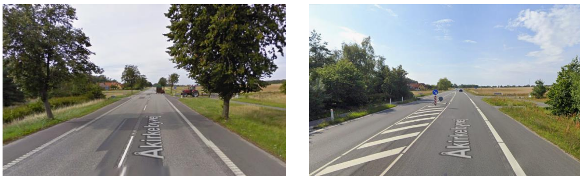
Figur 10. Åkirkebyvej i Bornholms Kommune sydøst for Rønne. Fotos fra Google Streetview september 2010 før anlæg af midterheller (til venstre) og august 2019 efter anlæg af midterheller (til højre).
