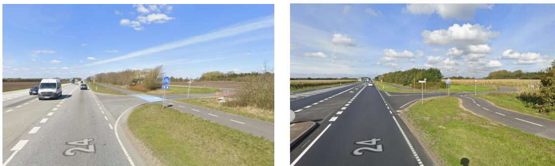
Figur 11. Varde Hovedvej/Kærbøl Markvej i Esbjerg Kommune nord for Ribe. Fotos fra Google Streetview april 2021 før anlæg af andet krydstiltag (til venstre) og oktober 2021 efter anlæg af andet krydstiltag (til højre).
