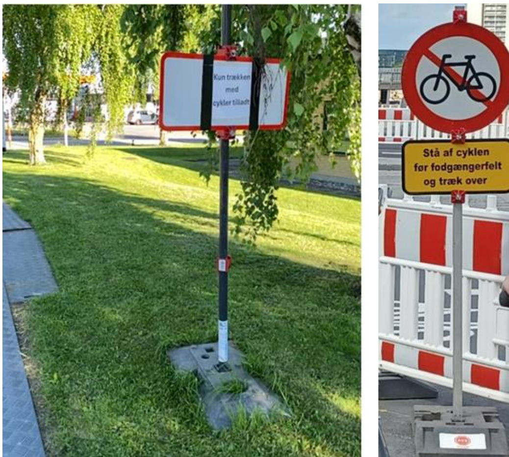
Foto 7. Illustration til spg. 29. Foto til venstre viser et eksempel på skiltning på strækning og foto til højre et eksempel på skiltning i et kryds.
