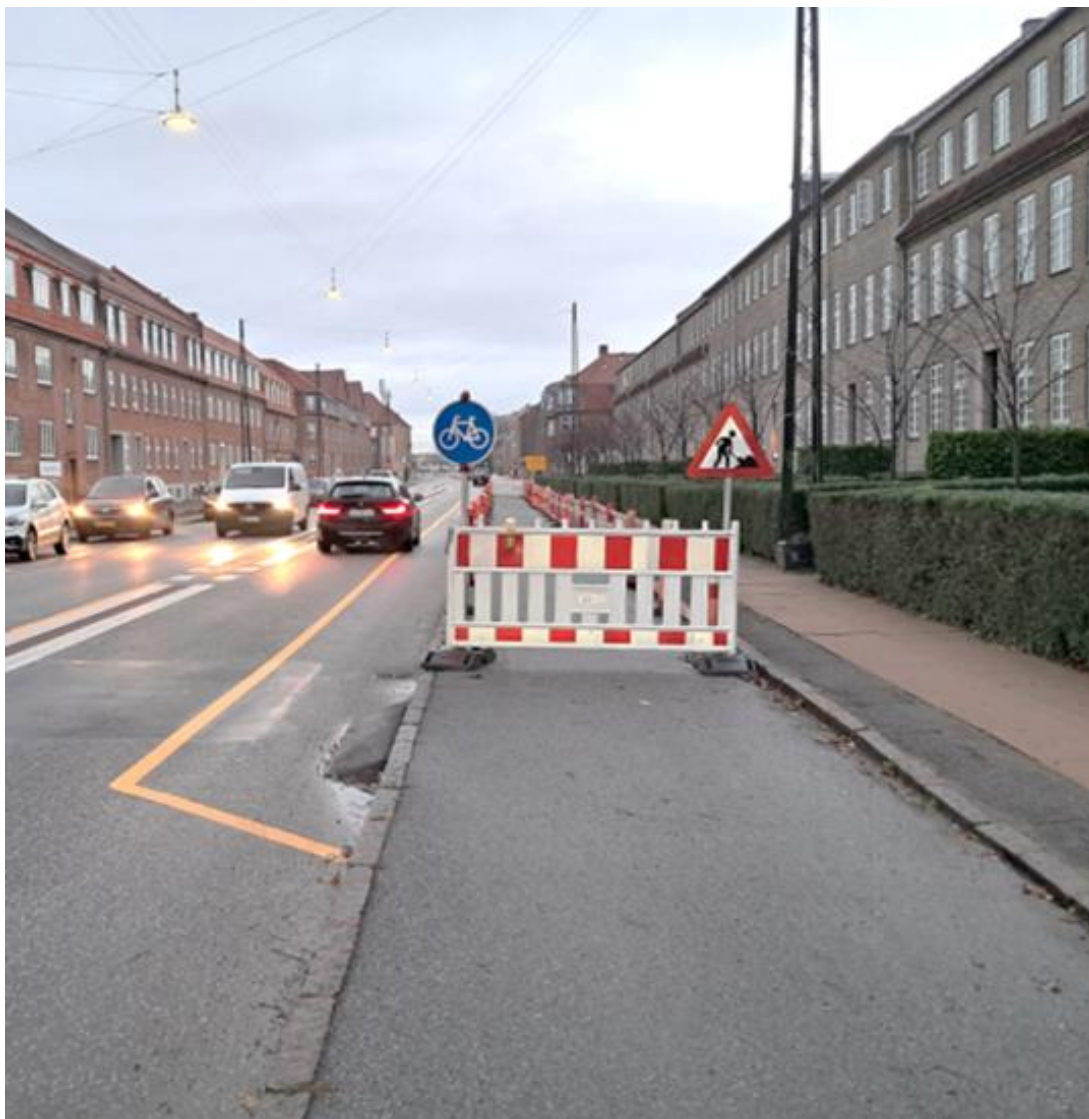
Foto 13. Illustration til spg. 53, 54, 55 og 56. Vejarbejdsopstilling 2. Cykelsti spærret. Cyklister henvises til vejbanen, adskilt fra bilerne med en gul delelinje.
