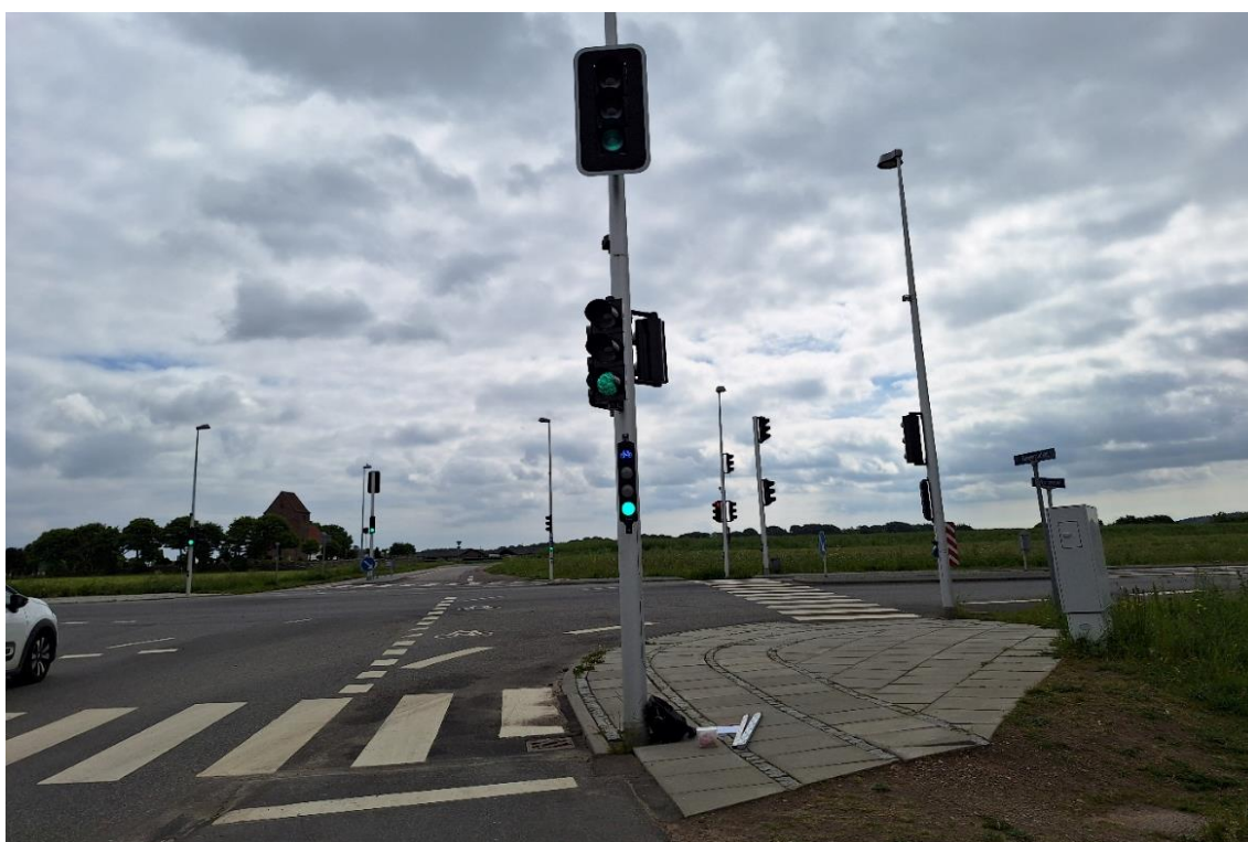
Figur 4. Foto fra krydset Bjerrevej / Højagergårdsvej / Kirkevej, der er taget i 120 cm øjenhøjde, 630 cm bag signalet og 1 m til venstre for standen.
