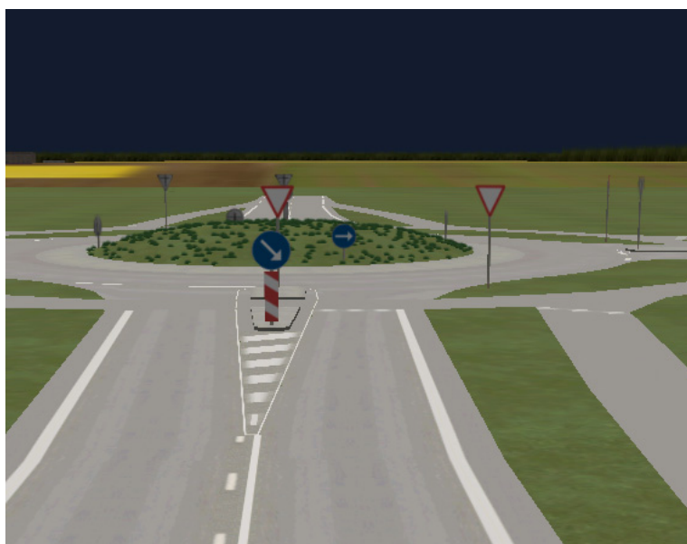
Figur 5. På billedet ses en rundkørsel med tilbagetrækningslængde på 3 m. Her er det bilister der skal holde tilbage for cirkulerende cyklister. For rundkørsler med tilbagetrukket cykelstikrydsning på mere end 5 m er det den krydsende cyklist der har vigepligt
