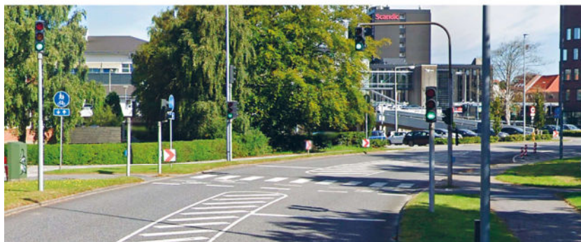
Figur 2: Vejsti-kryds med tre slags regulering. Stitrafikanter har ubetinget vigepligt (øverst), vejtrafikanter har ubetinget vigepligt (midt) og signalregulering (nederst).
