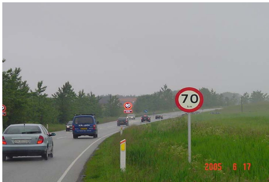
Figur 3.1: Hundestedvej. Hastighedsgrænsen 70 km/t skiltet med fast tavle reduceres til 60 km/t, 200 m før krydset, når VMS-tavlen tændes.
