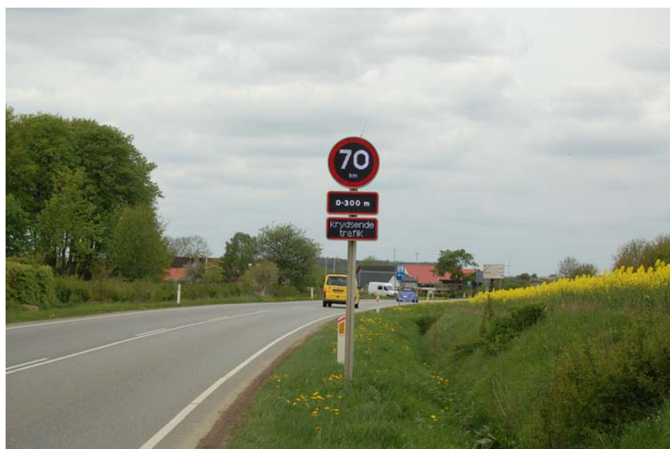
Figur 3.8: Aktiveret VMS tavle med undertavle, der informerer bilisten om, at hastighedsgrænsen reduceres til 70 km/t fordi der er krydsende trafik
