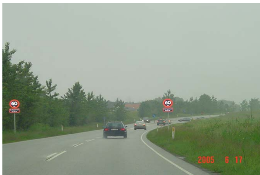
Figur 3.2: VMS – tavlen tændes, når der detekteres trafik fra sidevej Undertavlen viser ”Svingende trafik”
