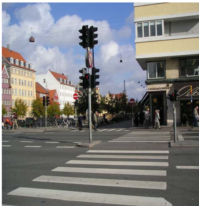
Foto 4. Fodgængerfeltet ved Torvegade ved Overgaden Oven Vandet. Foto er taget fra Christianshavns Metro mod Overgaden Oven Vandet
