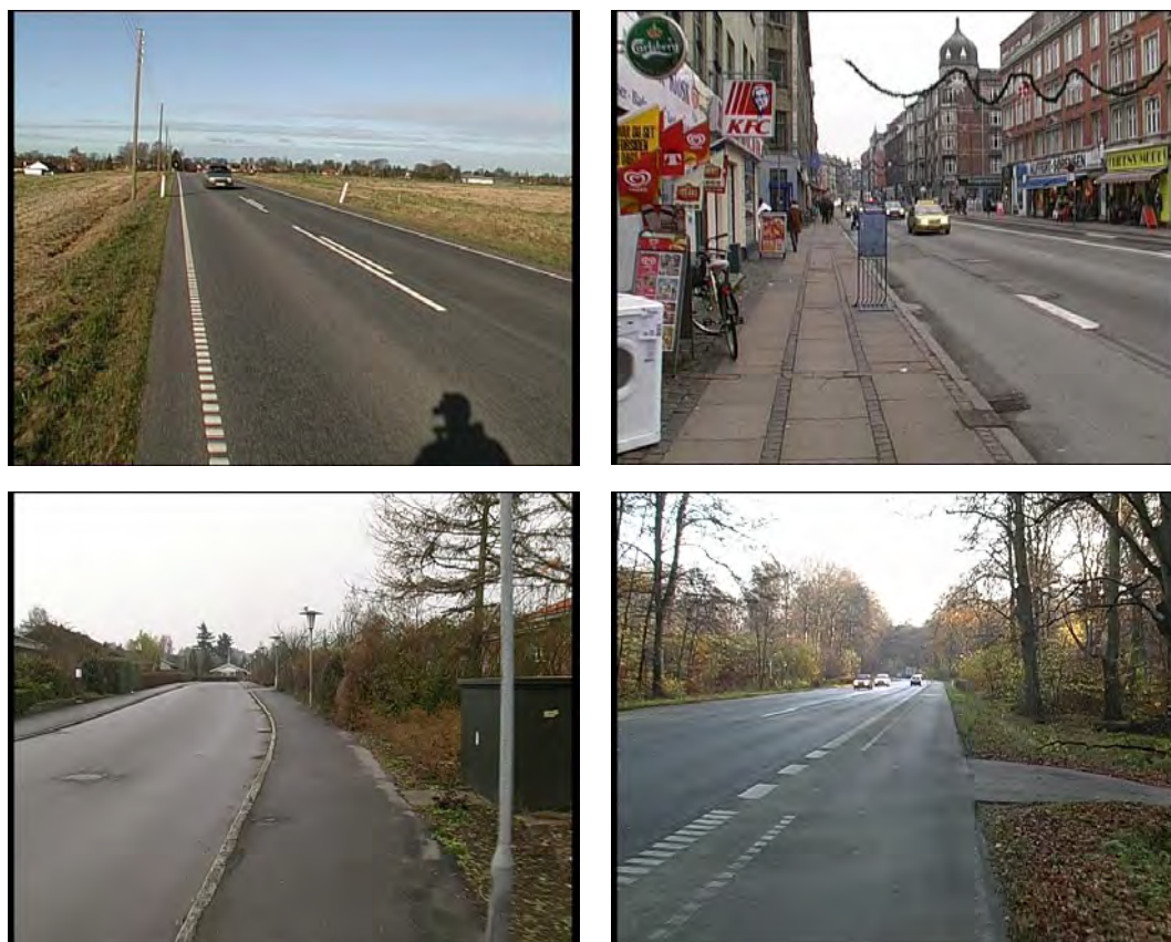
Figur 1. Vejstrækningerne i undersøgelsen er meget forskellige, her illustreret med fotos fra fire vejstrækninger.
