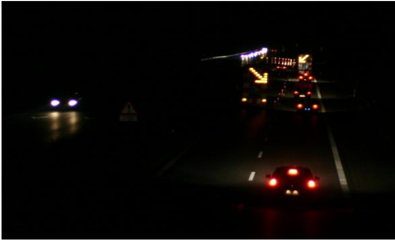
Figur1: Afmærkning af vejarbejde med trafikoverledning på motorvej i mørke.
