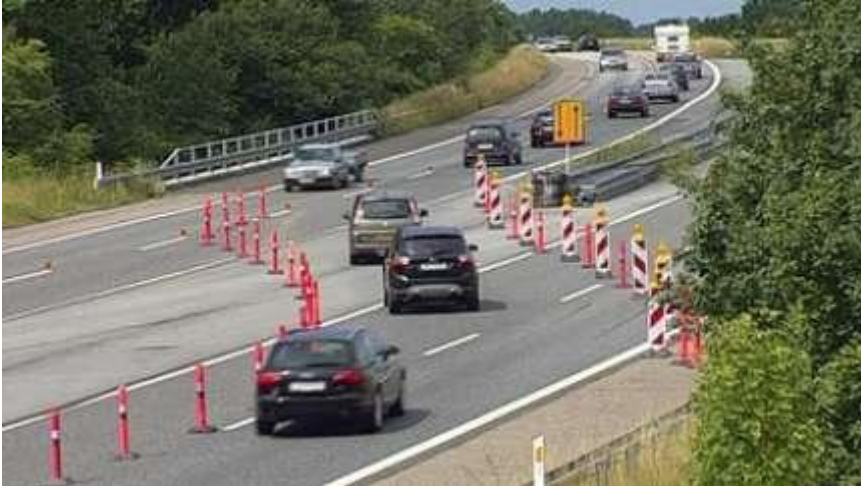
Figur 3: En række med 10 gule blinklamper på baggrundsafmærkning N42 afgrænser højre side af kørearealet ved trafikoverledning på motorvej
