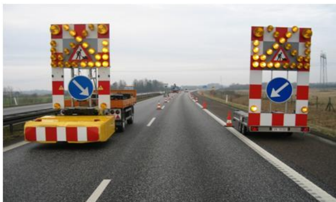
Figur 1: Med to tavlevogne dannes en ”port”, der videreføres forbi arbejdsområdet ved brug af to keglerrækker der afgrænser begge sider af køresporet
