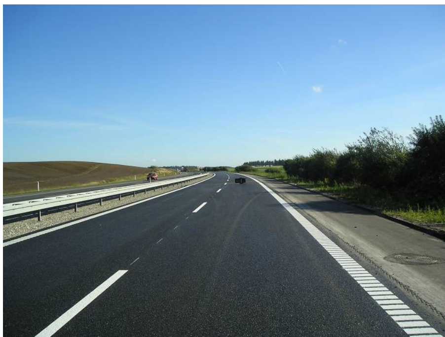
Objekt 6 (60 cm) – liggende plastikhavestol
