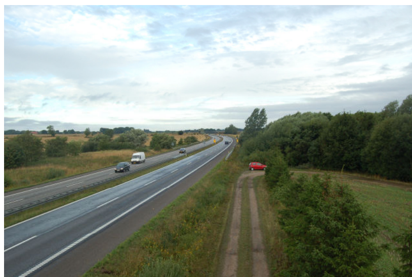
Figur 2.2: Forsøgsstrækningen på motorvej M40 set mod vest
