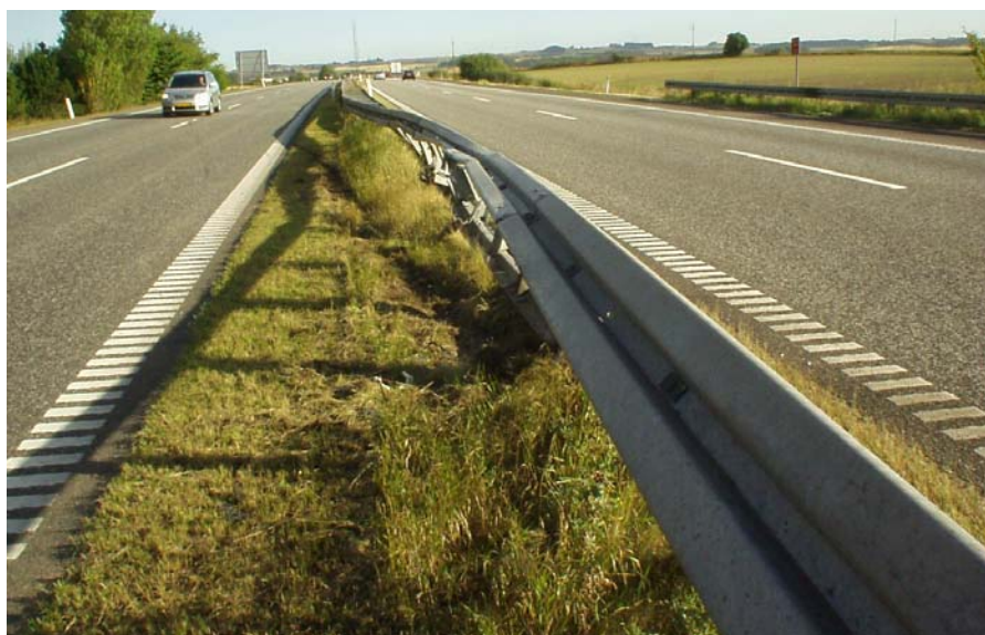
Dobbeltsidet stålautoværn med sigmaprofil. Efter at køretøjet (personbil) har ramt midterautoværnet ruller/vælder køretøjet. Foto Vejdirektoratet.
