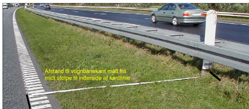
Foto 1. Måling af midterautoværnets afstand til vognbanekant. De to sorte streger markerer hvorfra og til der måles. Foto: Distrikt Syd.
