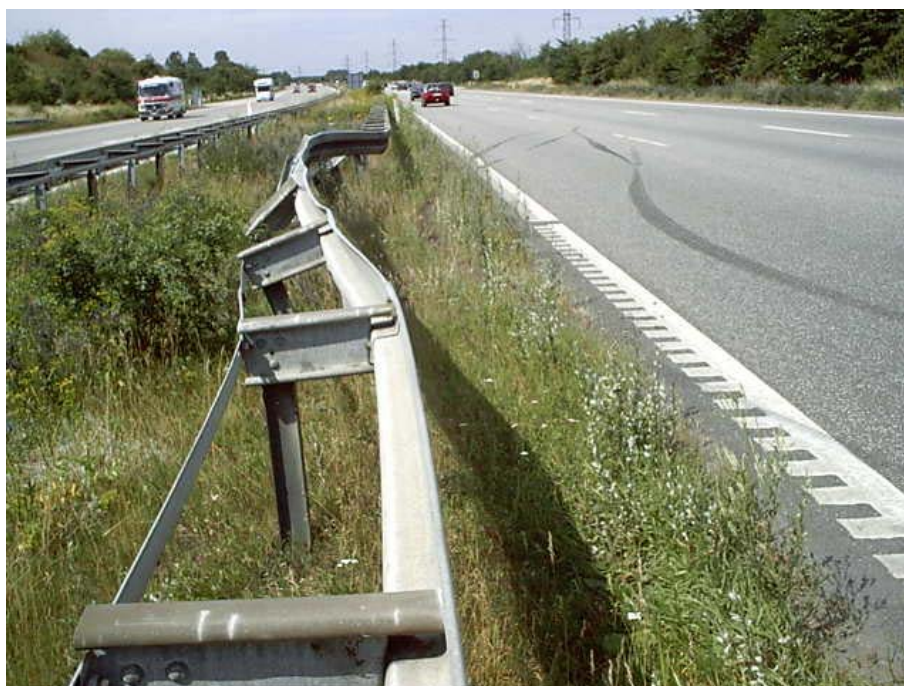
Enkelt-sided midterautoværn med IPE profil. Foto: Vejdirektoratet.
