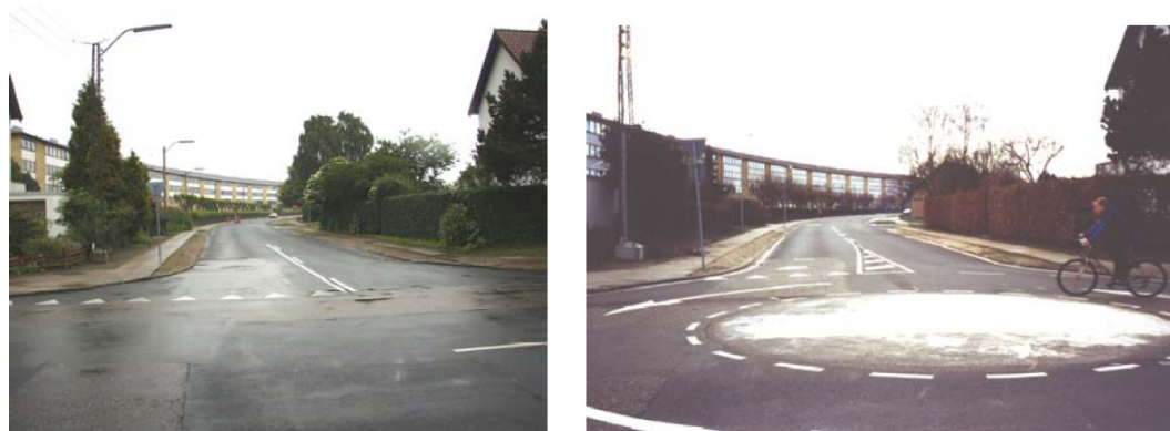
Figur 3. Eksempel på kryds før og efter anlæg af minirundkørsel. Her er krydset set fra Kallerupvej ned ad Ørnfeltvej.
