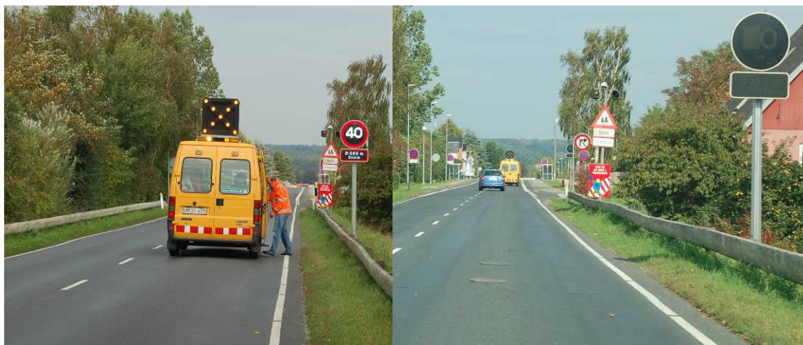
Figur 3.4: Udlægning af HiStar plader. Pladerne monteres på vejbanen midt i køresporet. Antal og placering af plader har været ens for Før, Efter og Efter/Efter registreringerne.
