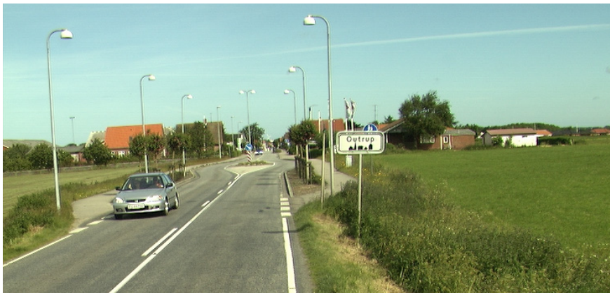
Foto 2.2 Fysisk byport med en længere fysisk udstrækning. Byporten består af en byzone-tavle (E55) som er suppleret med en række fysiske foranstaltninger. (Outrup i det tidligere Ribe Amt).
