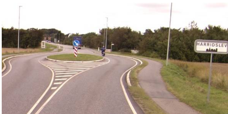
Foto 3.20 Byport i Harridslev. Byzonetavle på alm. stander samt klumphelle.
