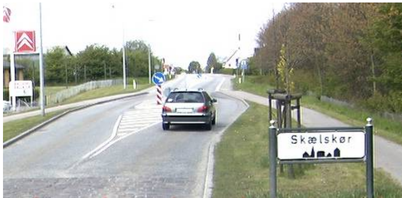
Foto 3.19 Byport i Bregninge. Byzonetavle på specialstander, helle, forsætning af kørespor i begge retninger samt ændring i belægning (chaussésten kan anes nederst til højre).
