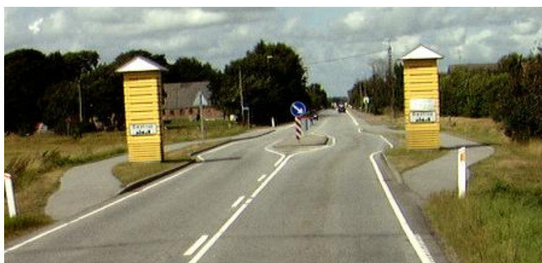
Foto 3.12 Byport i Døstrup. Byzonetavle på særlig stander, midterhelle samt fartviser (ses kun svagt).
