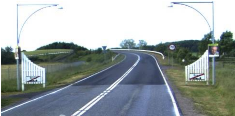
Foto 3.1 Byport i Ørbæk. Særlig placering af byzonetavle/ophør af byzone på hvide havelåger samt særlig belysning.
