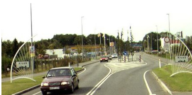
Foto 3.13 Byport i Kruså. Byzonetavle på særlig stander og midterhelle i forbindelse med sidevej.
