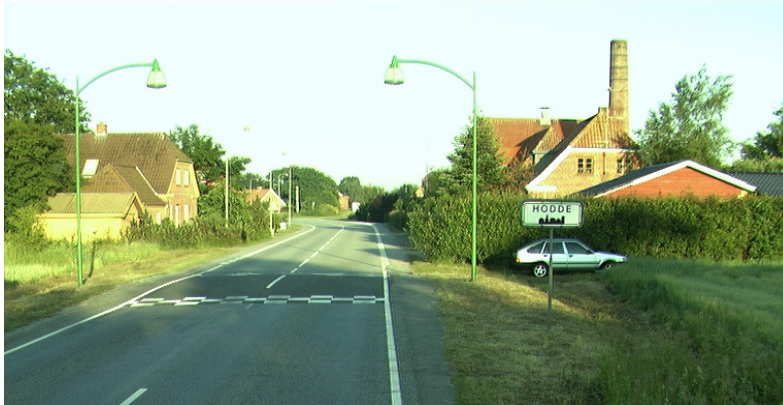
Foto 3.6 Byport i Hodde. Byzonetavle, bump og særlig belysning.
