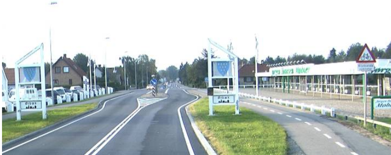
Foto 3.3 Byport i Ørbæk. Speciel udformning af byportskilt i form af et ståltårn. Desuden helleanlæg og forsætning af begge kørespor.
