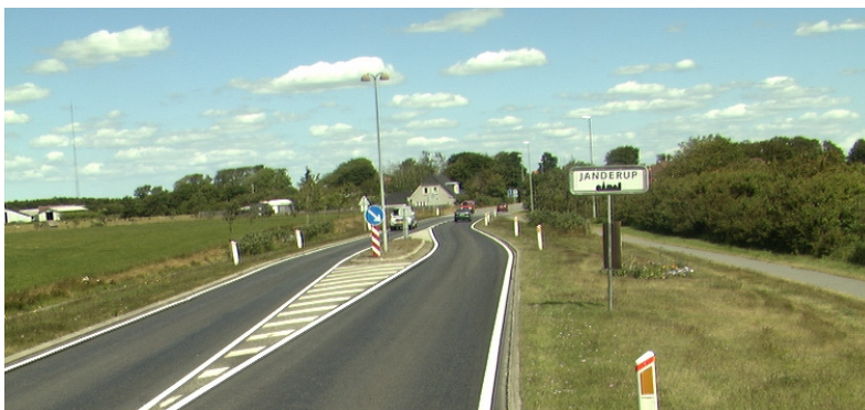
Foto 3.7 Byport i Janderup. Byzonetavle og helleanlæg. Senere (efter efterperioden for byportanlægget) er der opsat permanent fartviser ved spærrefladens spids i byzone).
