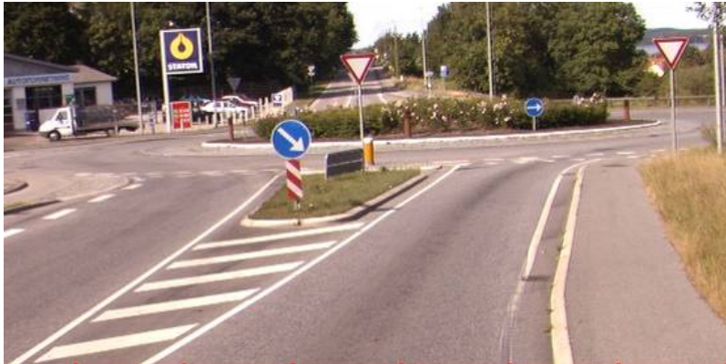
Foto 3.20 Byport i Mariager. Rundkørsel. Byzonetavle på alm. stander ses ikke af foto!
