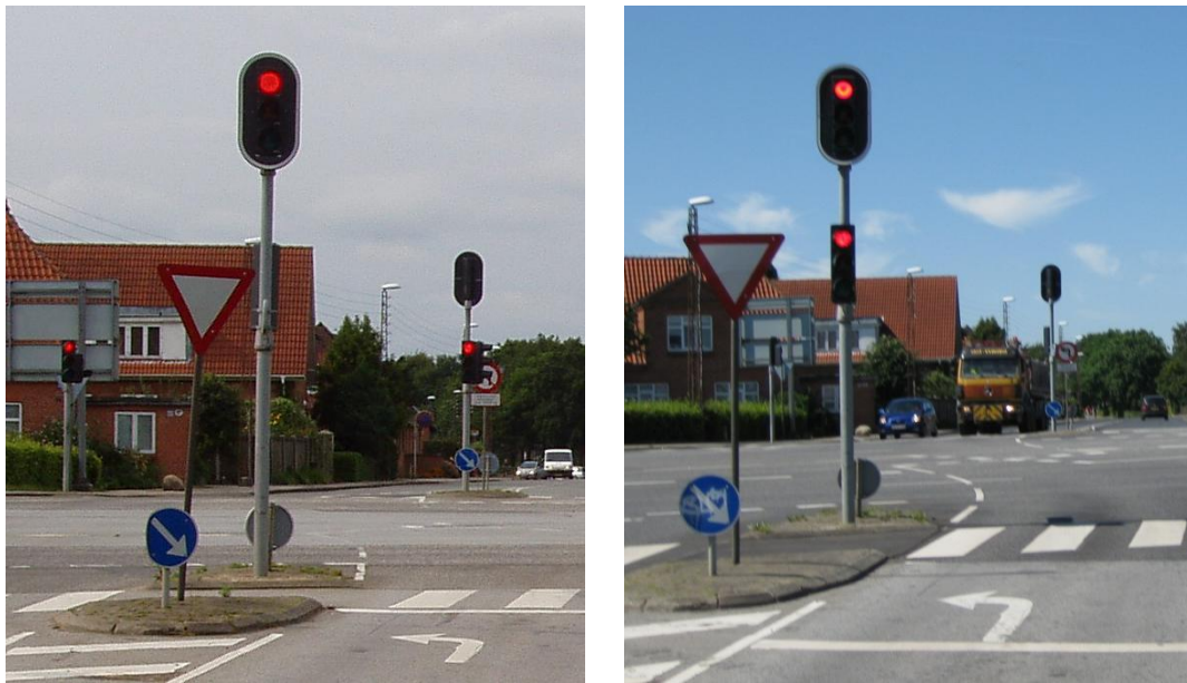
Figur 2. Fotos af ombygget kryds hhv. før (venstre) og efter (højre) ombygning.
