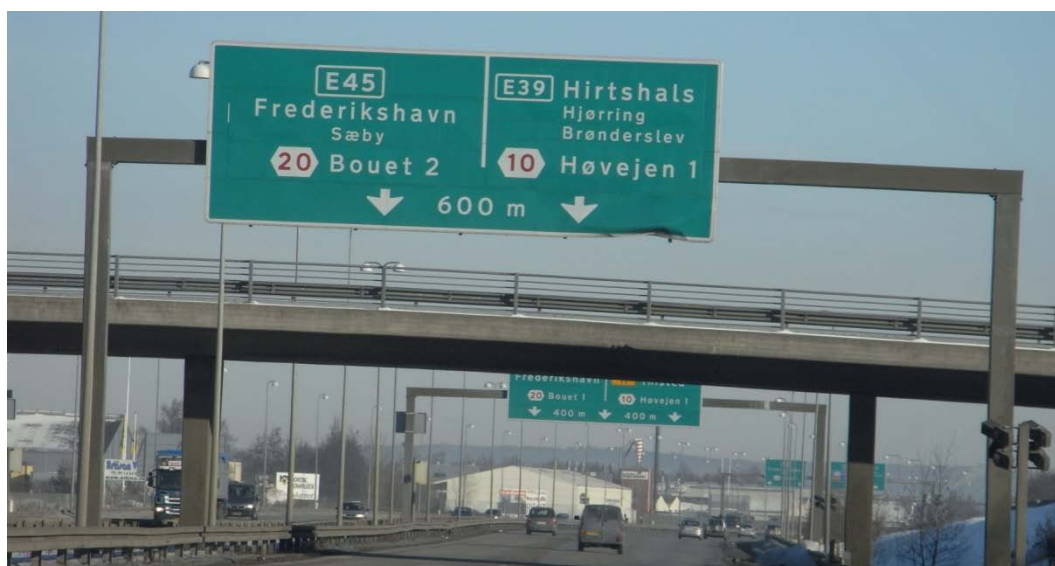
Portaltavle, S5, med angivelse af vognbaner. Portaltavlerne S6 og S7 ses i baggrunden.
