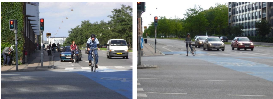
Figur 4.2. Fotos af krydset før (til venstre) og efter (til højre) ombygningen. I efterperioden er etableret cykelbane frem til krydset samt en blå cykellomme, som er placeret fra fortovskant til slutning af højresvingbanen. Der er ikke noget cykelsymbol i cykellommen.
