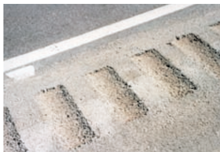
Figur 3. Nedfræsede rumlestriber [8] skæres ud i den eksisterende vejbelægning ved brug af en roterende tromle forsynet med skærehoved.
