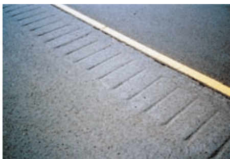
Figur 2. Formtrykte rumlestriber [8]. De etableres i den varme asfalt ved brug af en tromle forsynet med en bjælke, der former en stribe, når den trykkes ned i asfalten.
