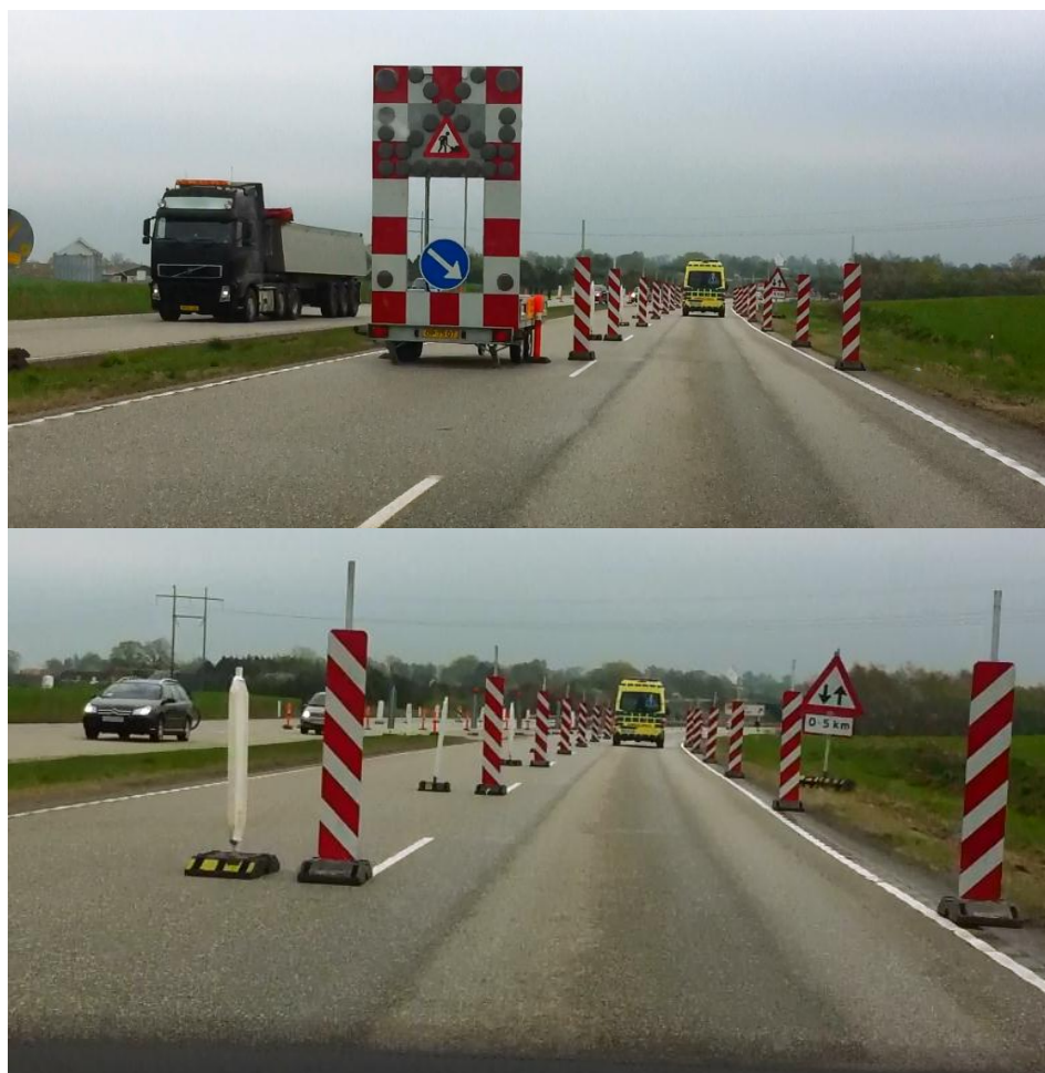
Etape 1 – N42 korridor, afstand mellem N42 tavler, t = 15 m. Foto i køreretningen (mod øst).
