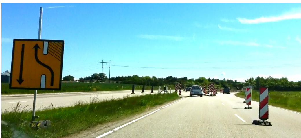
Foto fra Etape 2. For enden af N42 korridoren har trafikanterne mulighed for at fortsætte mod øst ad Skovvejen mod venstre – eller køre fra til højre ad frakørselsrampen mod Ringstedvej. Bemærk tavlen til venstre, som ikke stemmer helt overens med afmærkningen på stedet. Foto i køreretning mod øst.
