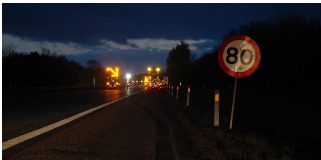
Testopstilling med 1 powermoon. Foto taget i køreretningen (mod vest) inden passage af de to skiltevogne (ca. km 91/0600).
