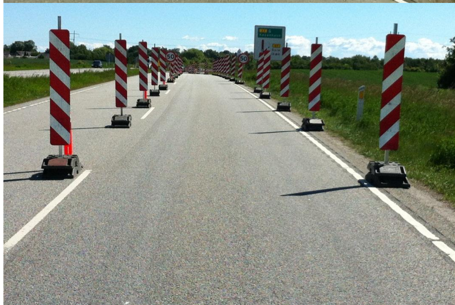
Etape 2 – N42 korridor, afstand mellem N42 tavler, t = 7,5 m. Foto i køreretning mod øst.
