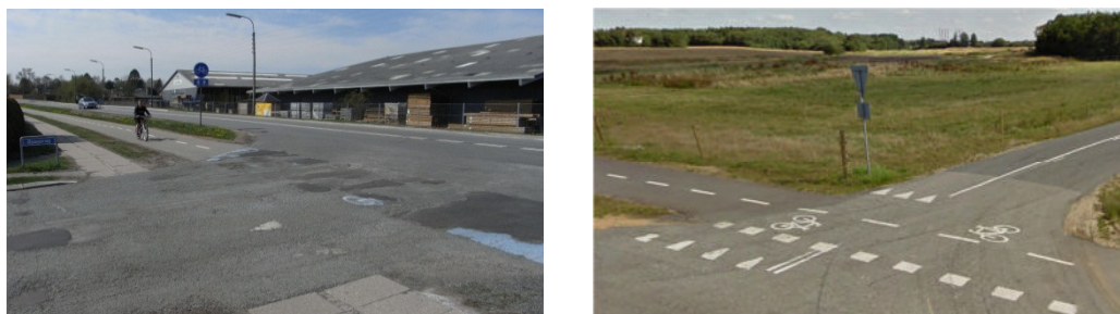
Figur 2: Til venstre ses en meget slidt afmærkning. Til højre er den "gamle" vigelinje bevaret.
