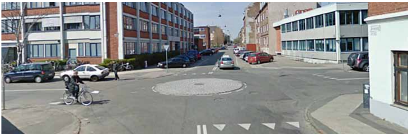
Figur 4. Minirundkørsel med 6,5 m midterø diameter, 5 m bredt cirkulationsareal, uden sekundærheller og uden cykelfacilitet – ikke så ringe endda.
