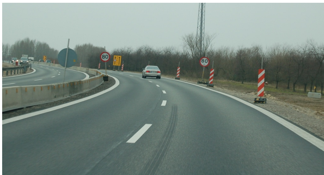
Figur 2: Foto fra interimsmotorvejen ved Slagelse i retning mod vest.
