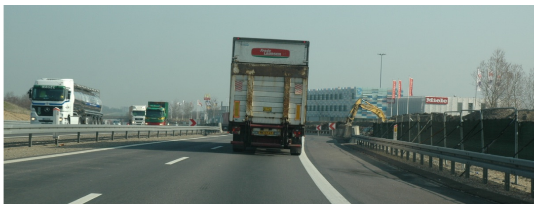
Figur 5: Interimsmotorvejen ved Vejle i nordgående retning, Bemærk den høje afskærmning til højre.
