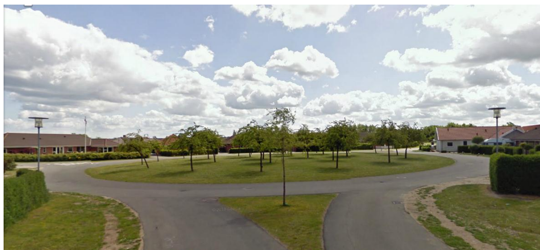
Figur 1. Et rundkørselslignende færdselsareal, men det er ikke en rundkørsel.
