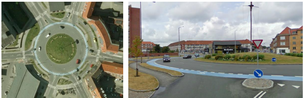
Rundkørslen ved Frodesgade/Gl. Vardevej i Esbjerg.
