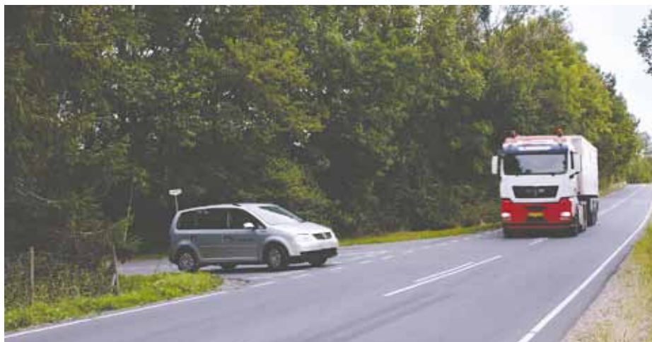
Figur 1. Beplantning langs vejen kan forringe oversigtsforholdene – hvilket betyder at trafikanterne kan have svært ved at se og erkende hinanden i tide.
