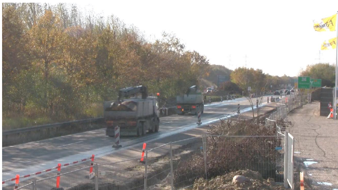
Foto 5. Indkørsel nr. 2. Lastbil kører ind i arbejdszonen uden konfliktende adfærd med andre trafikanter.
