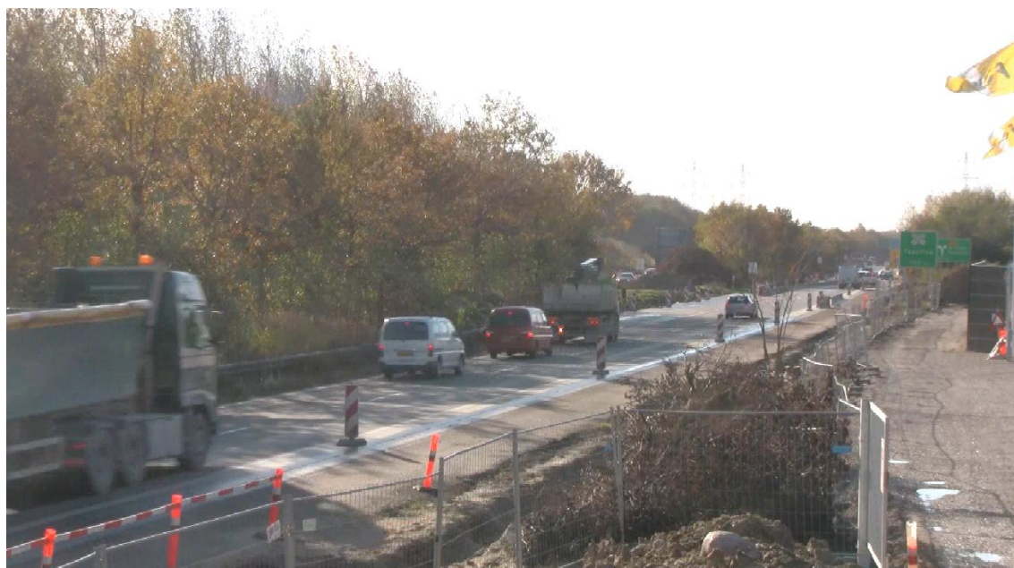
Foto 9. Indkørsel nr. 4. Den indkørende lastbil blinker til venstre og nedsætter hastigheden kort før indkørsel til arbejdsområdet, hvilket medfører at to bagvedkørende personbiler må bremse. Ingen alvorligt konfliktende adfærd. Skiltet hastighed er 80 km/t.
