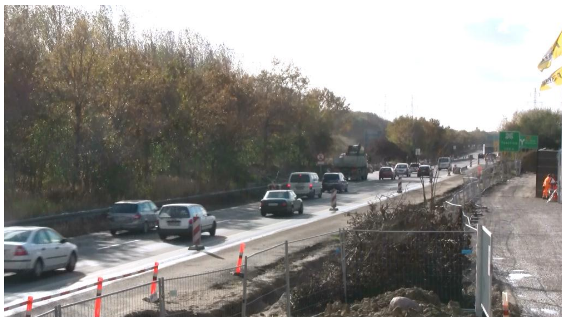
Foto 2. Screen dump fra Videokamera 2. Bruges til at registrere og dokumentere trafikanternes samspilsadfærd når et arbejdskøretøj kører ind/ud af arbejdszonen. Her holder arbejdskøretøjet stille i arbejdszonen.
