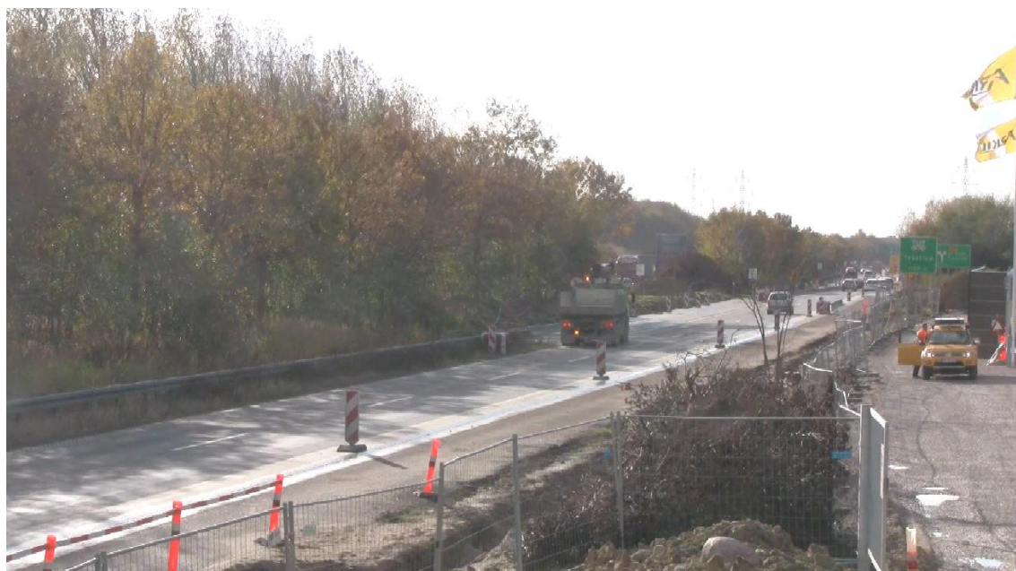
Foto 11. Indkørsel nr. 5. Lastbil blinker til venstre, nedsætter hastigheden og kører ind i arbejdszonen uden at være til synlig gene for andre trafikanter. Hastighedsbegrænsning på 50 km/t.
