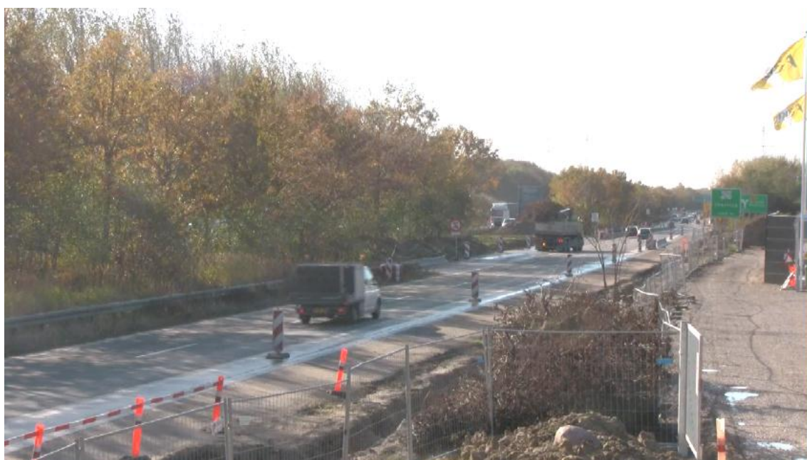
Foto 6. Udkørsel nr. 2. Lastbilchauffør har fået besked om at hastigheden er ned-sat fra 80 til 50 km/t og tilpasser sin kørsel ud fra arbejdszonen så den ikke er til gene for andre trafikanter.
