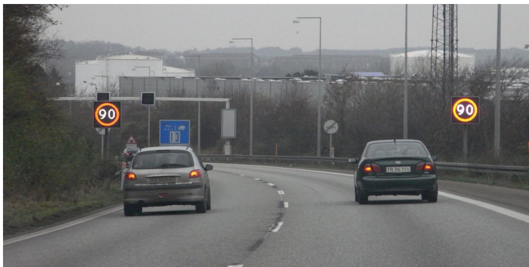
Variable hastighedstavler på den Nordjyske Motorvej.
