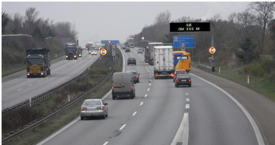
Informationstavle med køvarsling på den Nordjyske Motorvej.
