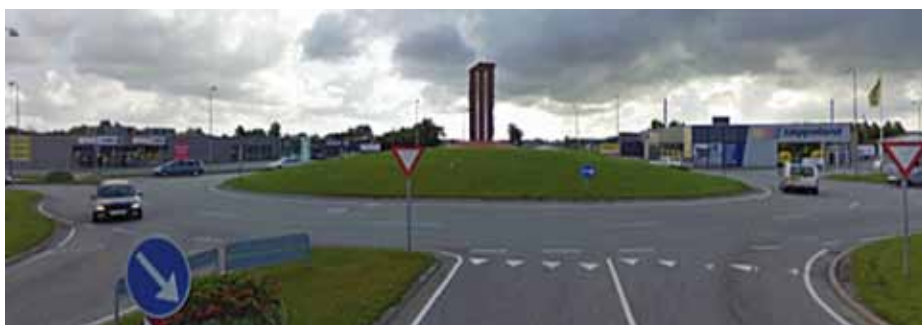
Figur 3. Midterøens højde måles fra cirkulationsarealets belægning til toppen af det, som man ikke kan se gennem, fx jorddynger, tæt beplantning, skulpturer, mv. Foto af Google.
