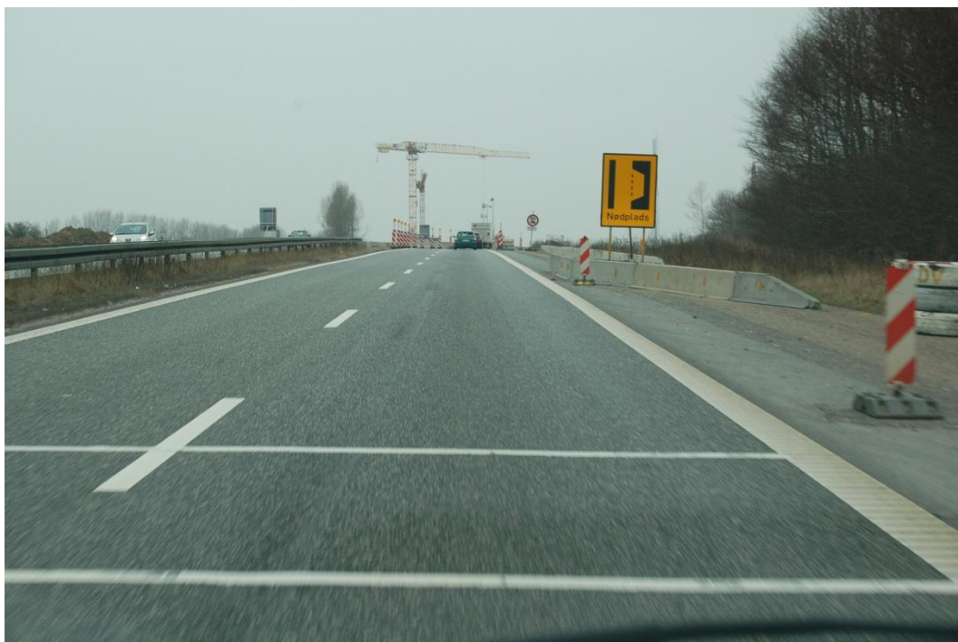
Foto 5 Afslutning på rumlestriber. Overledning til interimsmotorvej ses i baggrunden.
