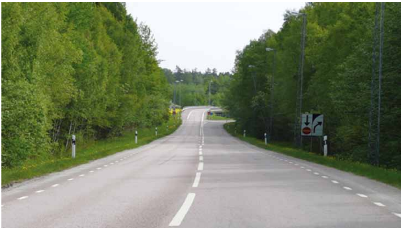
Figur 7. Design af ”halvt tilslutningsanlæg”, der kan vildlede bilisten til spøgelsesbilisme.
