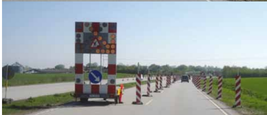
Figur 6. Skovvejen. Øverst: Referenceopstilling. Nederst: N42 korridor, hvor afstanden mellem N42-tavlerne er 7,5 m. Foto: Trafitec.
