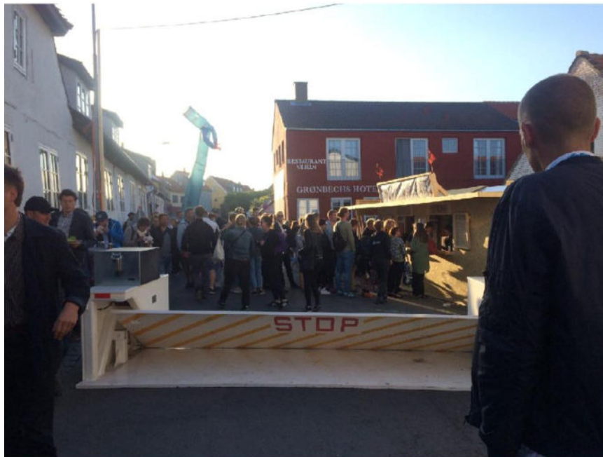
Figur 7.15 Eksempel på brug af aktiv vejblokker ved Folkemødet på Bornholm. Reference Terrorsikringshåndbog [3].
