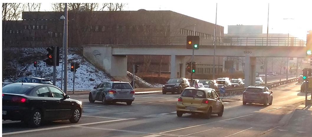
Figur 1: Eksempel på bundet venstresving i et 3-benet kryds uden delehelle mellem baner til venstresvingende og ligeudkørende motorkøretøjer.
