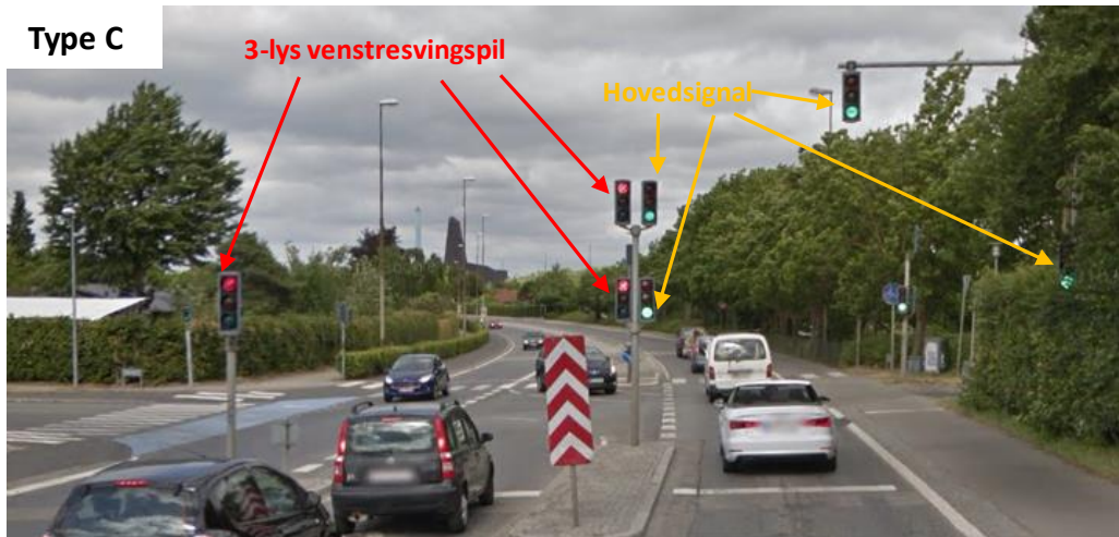
Type C: Hovedsignaler i krydsets for- og bagkant samt 3-lys venstresvingpile i krydsets forkant
