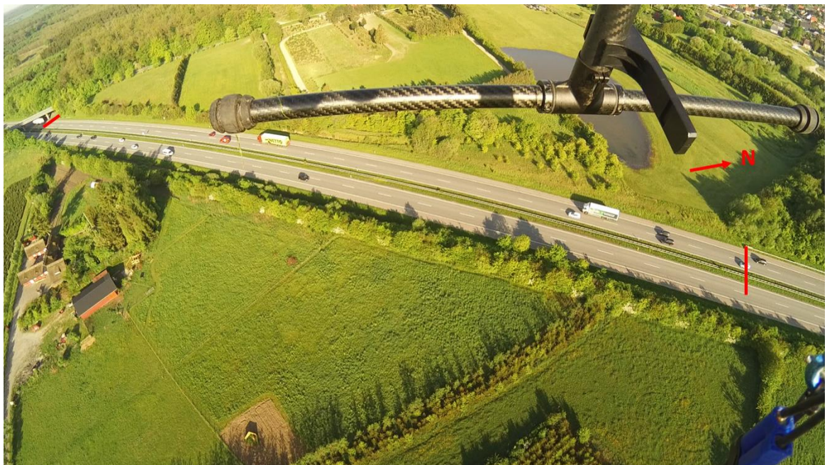
Figur 2.8: Sydmotorvejen E47 – den sydlige del af observationsstrækningen er 410 meter lang. Der observeres på trafik i sydgående retning.
