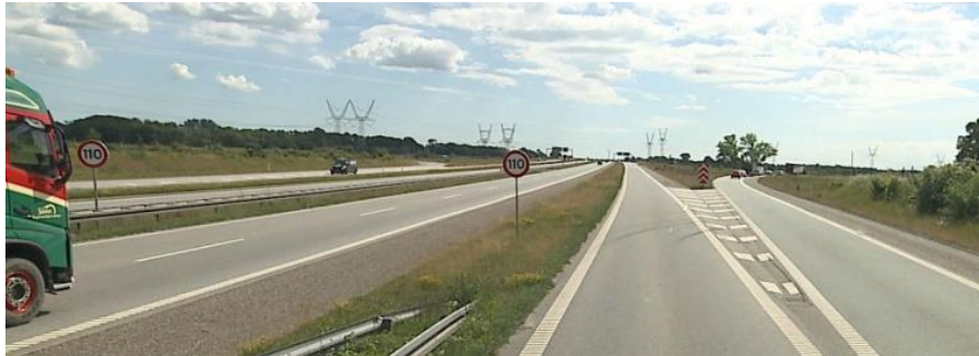
Figur 2.2: Hastighedstavler C55 på Svendborgmotorvejen i retning mod Svendborg. Versalhøjden er 340 mm.
