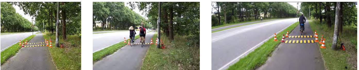
Figur 3. Præfabrikerede bump i gult/sort med højde 3 cm, bredde 48 cm. De sættes sammen af moduler, der er 60 cm lange. Til venstre ses design 3.1 med 2 bump med indbyrdes afstand på 1 m. I midten ses design 3.2 med et enkelt bump. Til højre ses design 3.3 med 2 bump med indbyrdes afstand 0,75 m.
