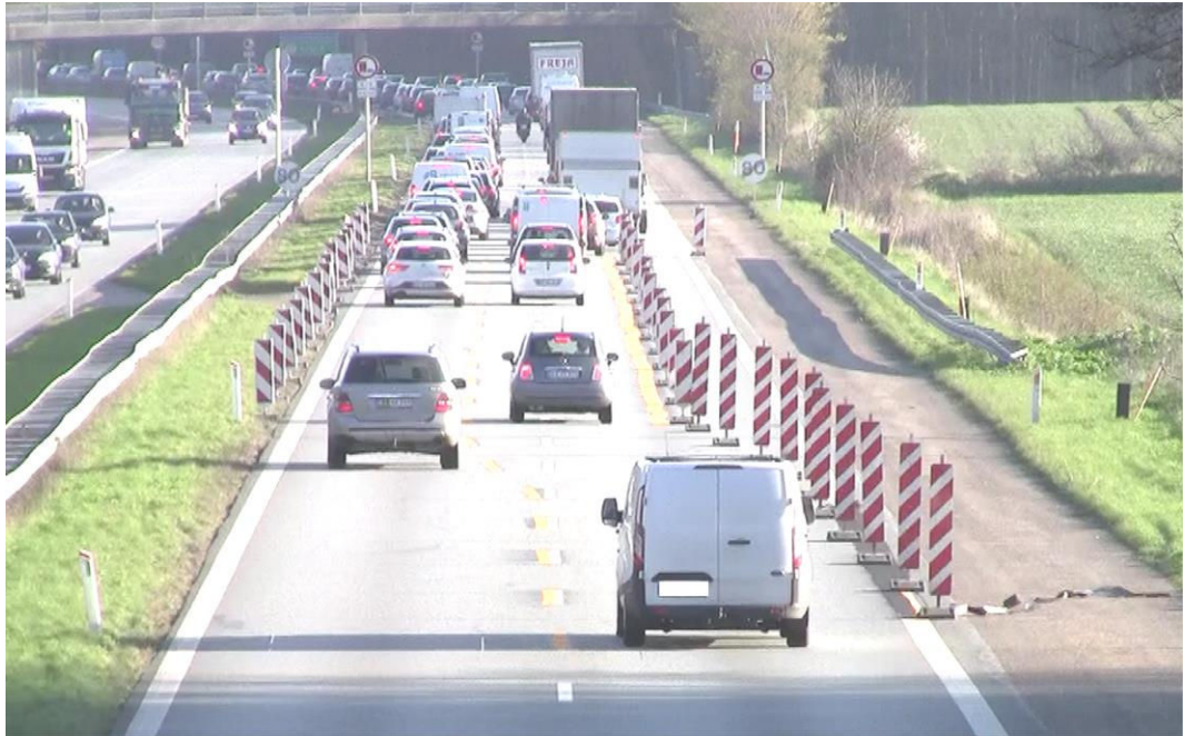
Figur 24: Eksempel på tilbagestuvning, hvor det er tydeligt, at det ikke er strækningen med smalle spor, der giver opbremsninger i trafikken, men en flaskehals længere fremme på strækningen.
