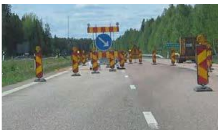
Figur 19.3: Opstilling SK med pilmønster på de lodrette sidemarkeringstavler.
