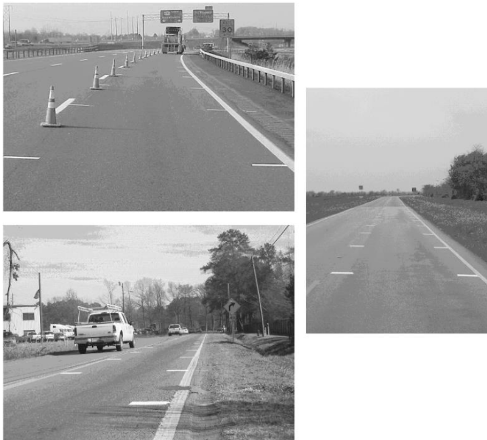
Figur 16.4: De periferiske optiske linjer i New York (øverst til venstre), Mississippi (nederst til venstre) og Texas (til højre)
