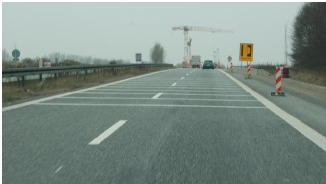
Figur 5.1: Faste rumlestriber på E20 umiddelbart før overgangen til den midlertidige vejstrækning, der førte trafikken uden om arbejdsområdet.
