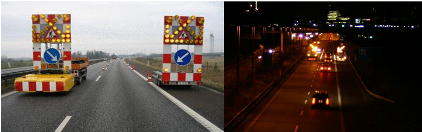
Figur 3.1: De to tavlevogne danner tilsammen en "port", der videreføres i en korridor etableret af to rækker markeringskegler N44.
