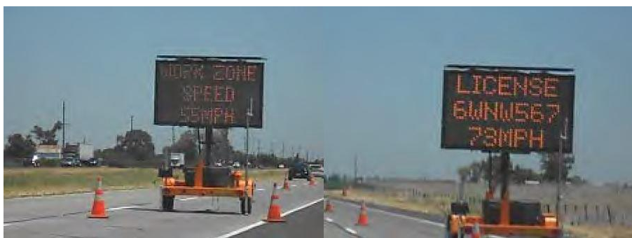
Figur 7.4: System med nummerpladegenkendelse og direkte "feed back" til bilisten, der kører for stærkt hen mod et vejarbejde er testet i Californien (USA).
