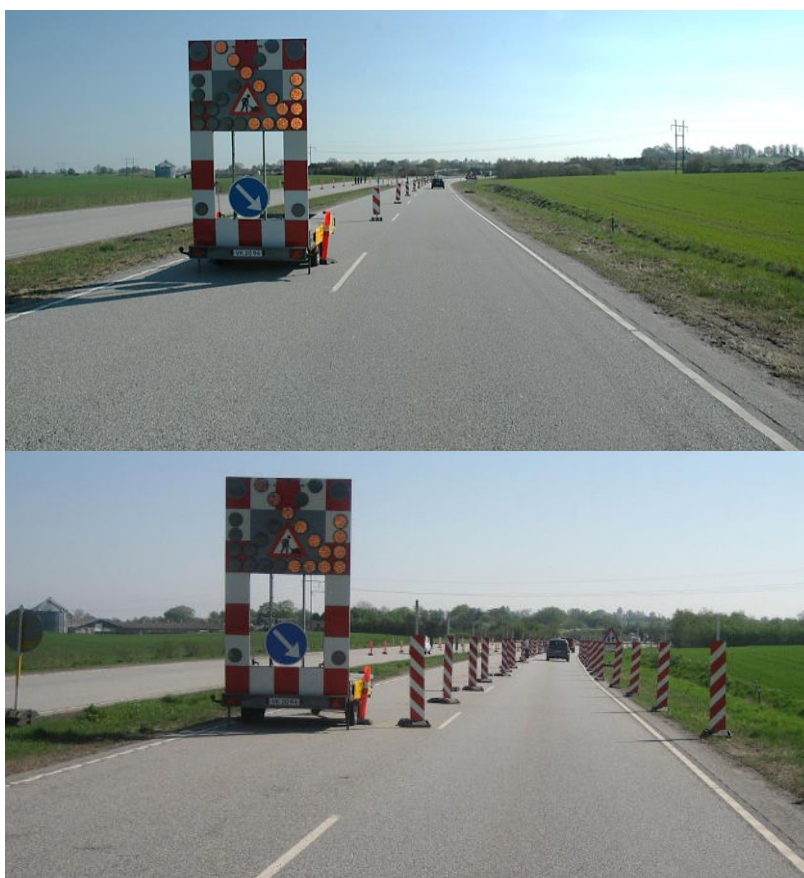
Figur 2.1: Korridorstrækningen med de 2 meter høje N42-tavler opstillet med 7,5 meters afstand på etape 1 (nederst) og tilhørende referencetrækning med standardafmærkning DRI-261 (øverst).
