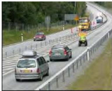
Figur 18.1: Forsøg med Lods ved reparationsarbejde af autoværn. Foto: Åke Johansson [17].
