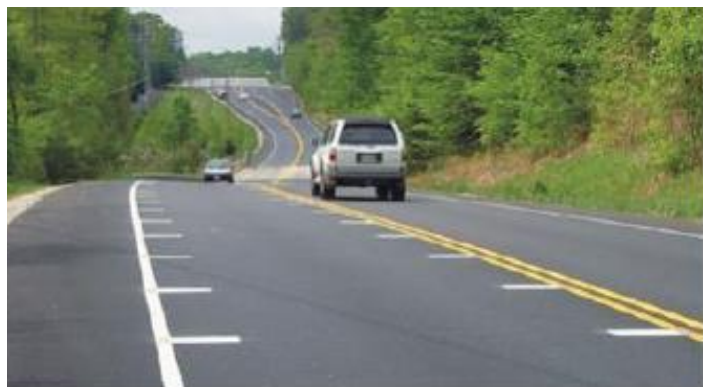
Figur 16.1: De optiske linjer er 30 cm lange og er påklisteret i begge sider vinkelret på køresporets sidelinjer. Foto til venstre er fra det svenske forsøg og foto til højre er fra et lignende forsøg i USA.
