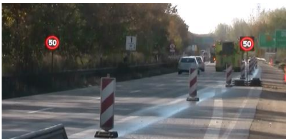
Figur 10.1: VMS-tavlerne aktiveres ved arbejds kørsel ud fra midterrabat for at få en midlertidig hastighedsbegrænsning på 50 km/t.
