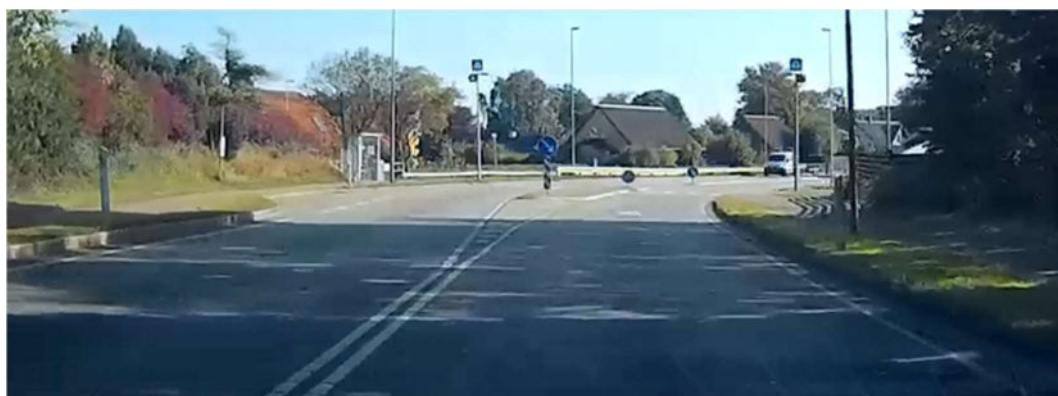
Figur 29: I køreretning mod Slagelse opnår bilister først fuld oversigt over fodgængerfeltet og sidearealerne 80-60 m før feltet pga. beliggenhed i højrekurve.
