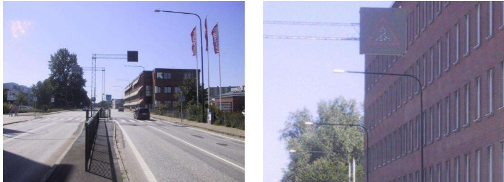
Figur 16: Galgeportal med VMS-tavle kombineret med gult blinklys ved fodgængere i felt i Malmö, Sverige (Eksempelbanken, ukendt årstal). Til venstre er VMS-tavlen slukket og til højre er den tændt. Erfaringer i konkret eksempel: Har observeret markant reducerede hastigheder, når signal er tændt.
