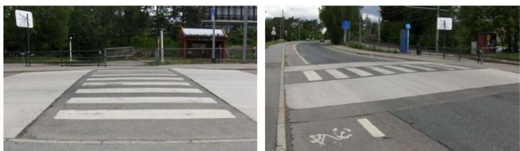
Figur 10: Fodgængerfelt på hævet flade (lys beton) i Oslo. Erfaringer i konkret eksempel: Mange fodgængere, få krydser uden for felt, lidt for høj fart blandt motorkøretøjer (forhøjning slidt), konflikter ved høj fart observeret (Sørensen og Nævestad, 2012).
