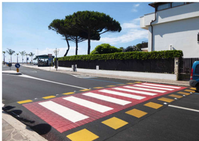
Figur 6: Kombination af rød baggrundsfarve, gul markering og vejbump med ukendt oprindelse.
