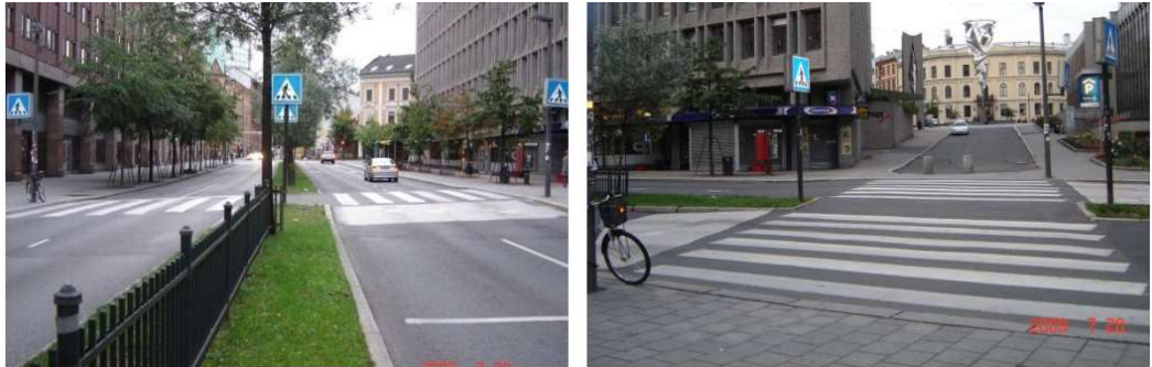
Figur 11: Fodgængerfelt med hævet flade (lys beton) og midteradskillelse i Oslo. Erfaringer i konkret eksempel: Mange fodgængere, få krydser uden for felt, mange motorkøretøjer, acceptabelt fartniveau (Sørensen et al., 2010). I dag er overgangen ombygget til signalregulering til trods for en god bedømmelse i 2010.
