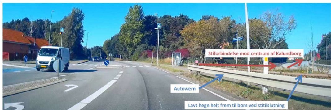
Figur 28: Stitilslutningen mellem fodgængerfeltet og stiforbindelsen mod centrum af Kalundborg er udformet, så det er besværligt for fodgængere og cyklister ikke at benytte fodgængerfeltet.
