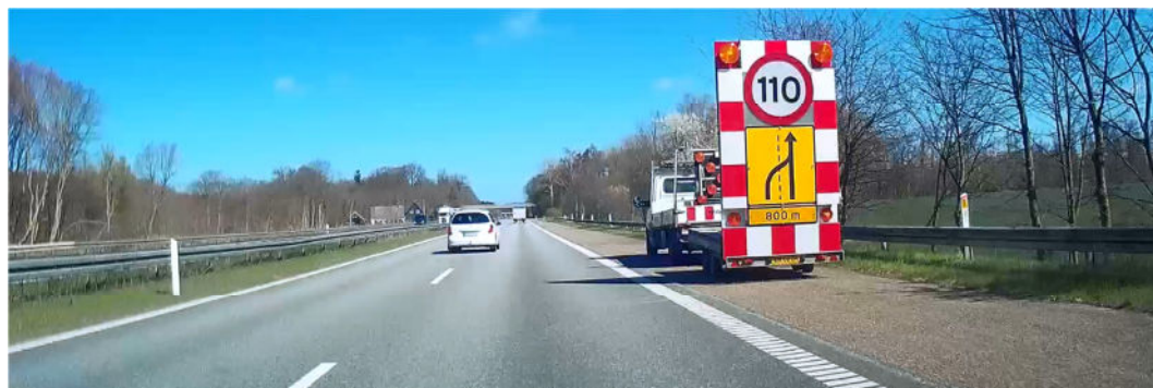
Figur 22: Ved MF0202C forvarsles indsnævringen 800 m før afspærringen.
