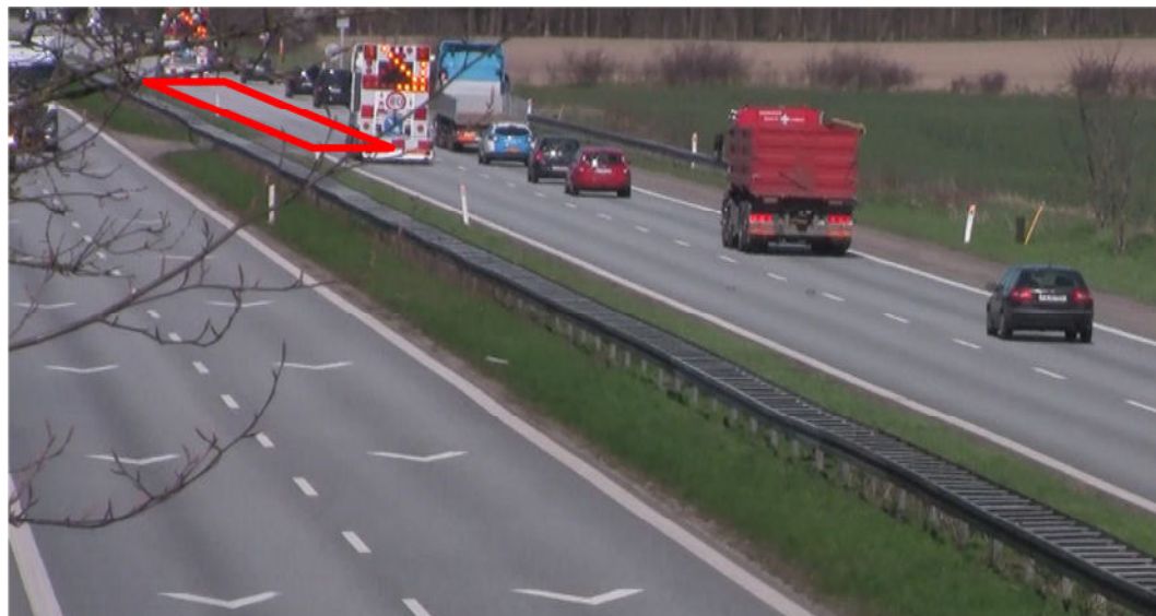
Figur 18: Det registreres, om trafikanter kører ind i det venstre spor (rødt felt) mellem de to TMA'er på MF0202A, MF0202B og MF0202C.
