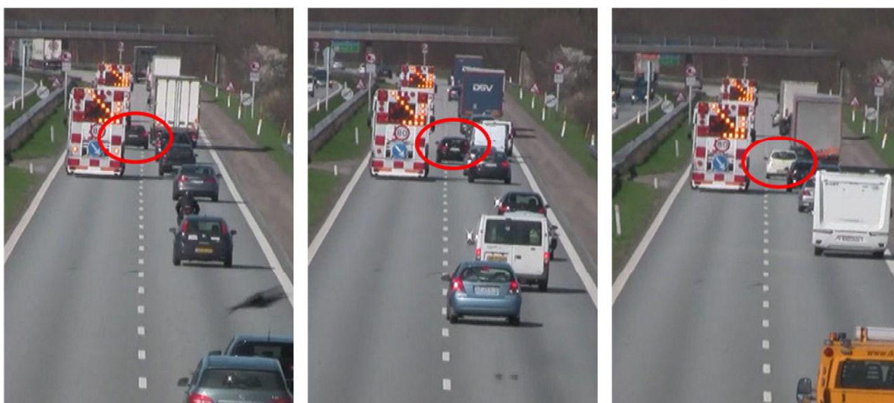
Figur 27: Eksempler på inddeling af trafikanter, der overskrider delelinjen til venstre spor i arbejdsområdet mellem de to TMA'er. Til venstre: minimum 50 % af køretøj i venstre spor, i midten: venstre hjulpar i venstre spor, til højre: kørsel på delelinjen.
