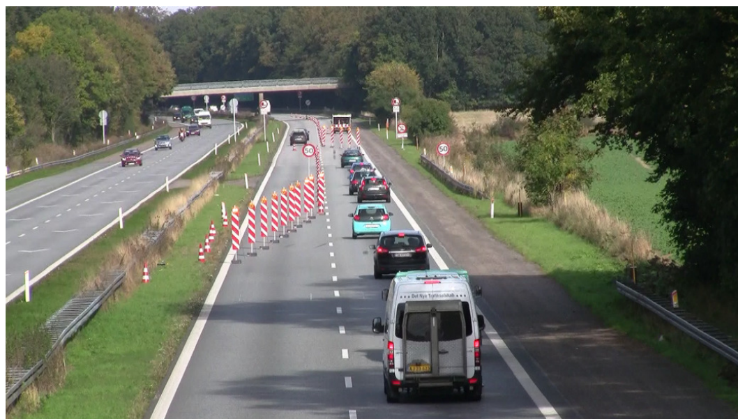
Figur 34: MF016C og MF016B er identiske med undtagelse af løbelys på N42 kantafmærkningen i forsætningen fra højre til venstre spor. Foto af MF016B.
