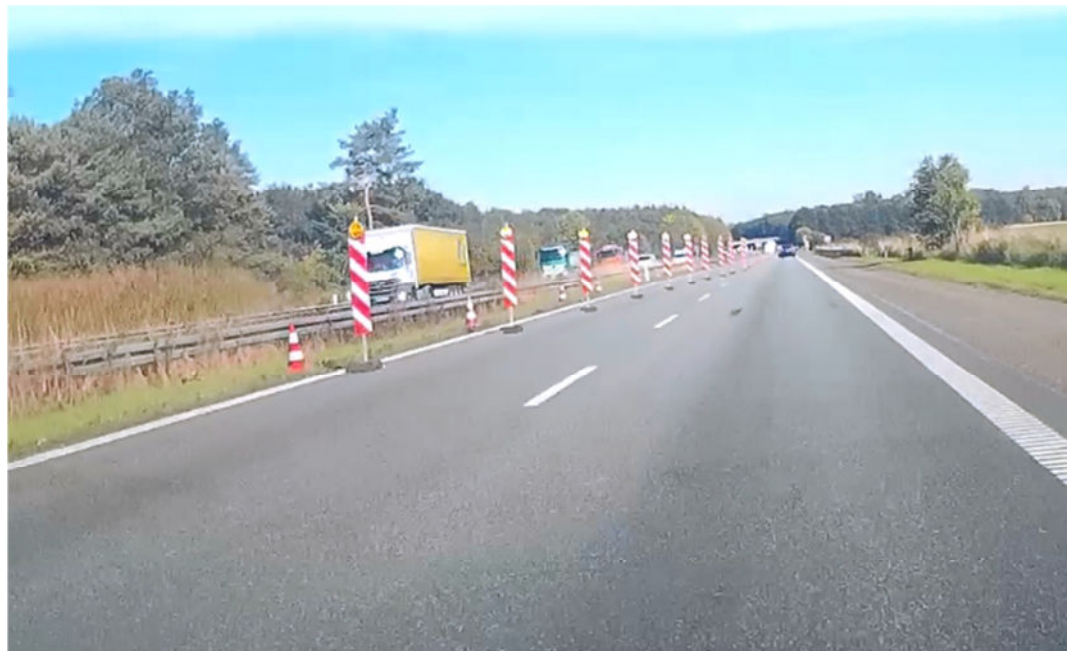
Figur 37: Indsnævringen til højre spor ved MF016B.
