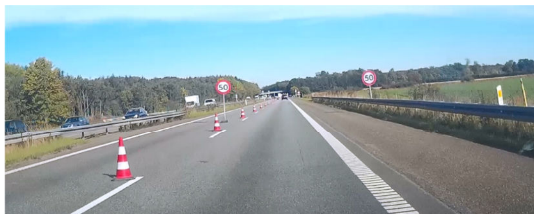
Figur 43: Nedskiltningen til 50 km/t sker mellem på det 1-sporede stykke mellem indsnævringen og forsætningen af trafikken fra højre til venstre spor.
