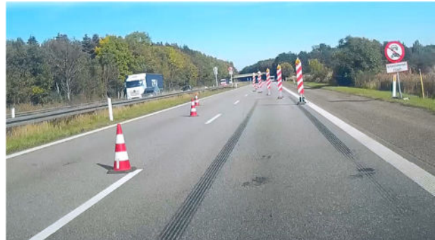
Figur 41: Forsætningen fra højre til venstre spor ved MF016C til venstre og MF016B til højre. Der anvendes flere kegler og N42 tavler i forsætningen ved MF016C end ved MF016B, som har løbelys på N42 tavlerne (svært at se på foto).
