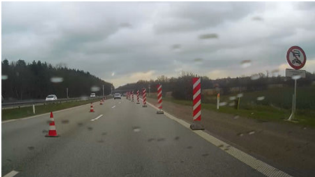
Figur 41: Forsætningen fra højre til venstre spor ved MF016C til venstre og MF016B til højre. Der anvendes flere kegler og N42 tavler i forsætningen ved MF016C end ved MF016B, som har løbelys på N42 tavlerne (svært at se på foto).
