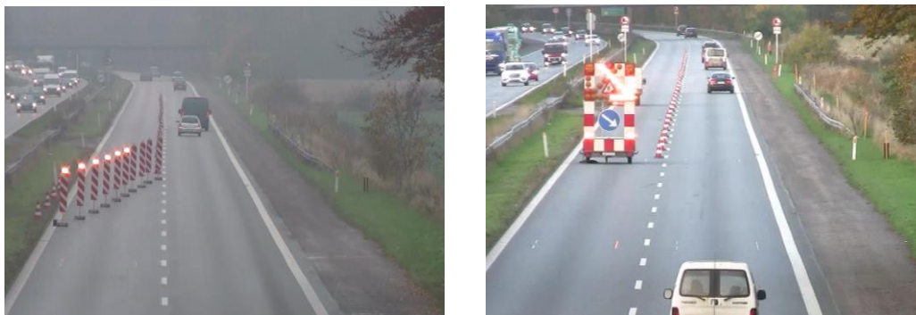
Figur 64: Til venstre MF012 og til højre MF015. Begge opstillinger lige før indsnævring til højre spor.
