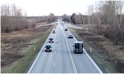
Figur 2. 2+1 vej med dobbeltoptrukket spærrelinje mellem køreretninger.
