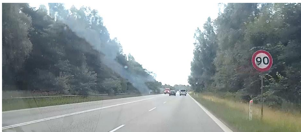
Figur 4: 2+1-strækning med hastighedsbegrænsning på 90 km/t.
