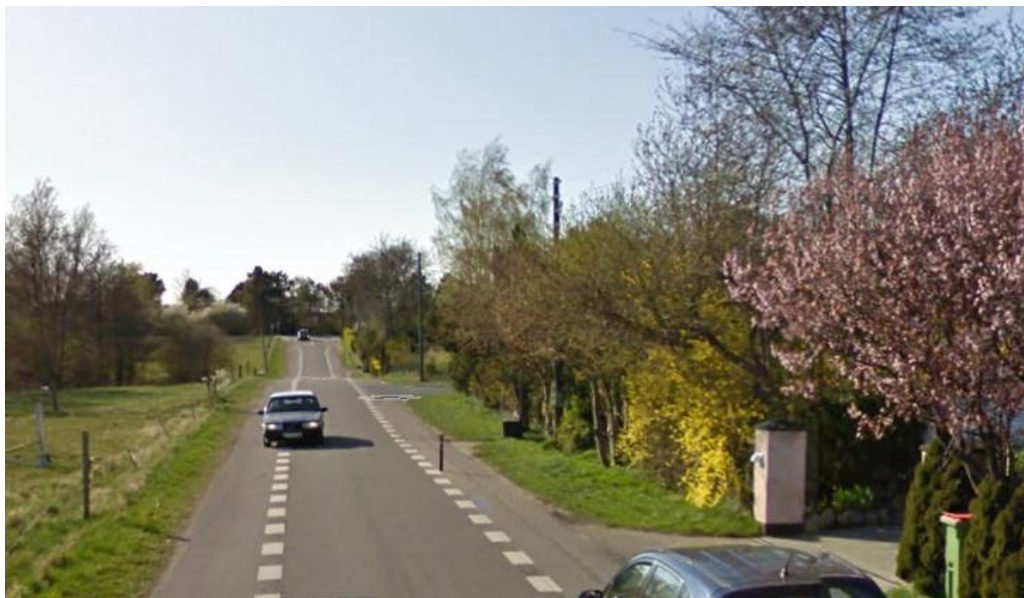
Figur 3.5. Eksempel på '2-1' vej hvor der er placeret eftergivelige pullerter i kantbanen. På 9 af de 55 '2-1' veje, er placeret eftergivelige pullerter i kantlinie eller kantbane. Oftest er pullerterne placeret forskudt skiftevis i højre og venstre side af vejbanen.
