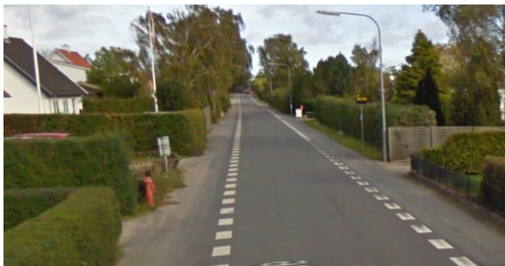
Figur 3.1. Bredde af kantbanen varierer både inden for den enkelte strækning, og strækningerne imellem. Her ses eksempelvis, at bredde af kantbane bl.a. afhænger af beplantning langs vejen (hæk).
