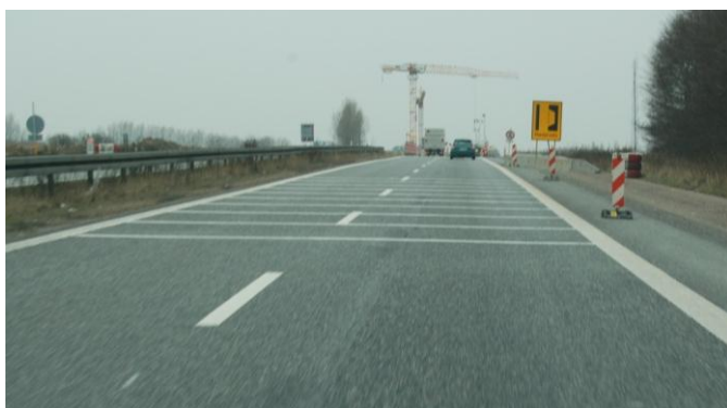
Figur 5.1: Faste rumlestriber på E20 umiddelbart før overgangen til den midlertidige vejstrækning, der førte trafikken uden om arbejdsområdet.
