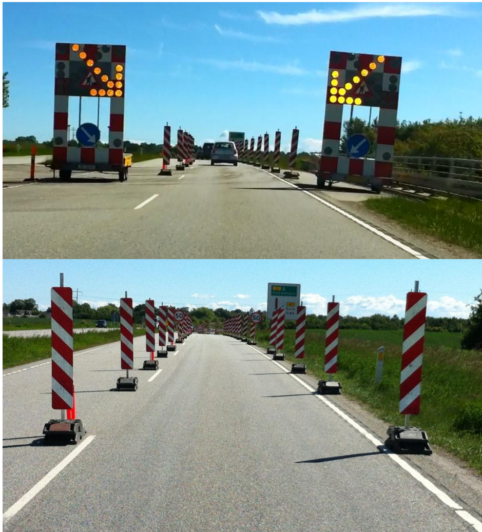
Figur 2.2: Korridorstrækningen på etape 2. Indgangen til korridoren er her markeret med to tavlevogne placeret med 4,5 meters afstand. Nederst ses den 3,65 meter brede korridor midt på korridorstrækningen etableret med de 2 meter høje N42 tavler.
