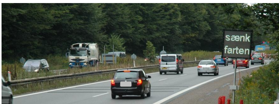
Figur 7.1: Sænk farten tavle ved vejarbejde på Helsingørmotorvejen ved Farum.
