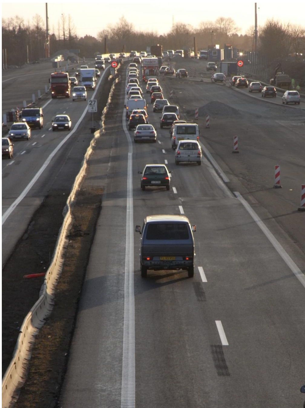
Strækningen på Holbækmotorvejen.
